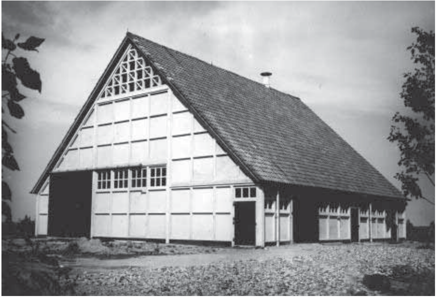
Eén van de bijna duizend boerderijschuren die Schokbeton in de Noordoostpolder plaatste, grotendeels bestaande uit prefabonderdelen, waardoor ze in korte tijd konden worden gebouwd. Begin jaren vijftig. Foto: collectie Frans Walkate Archief.
