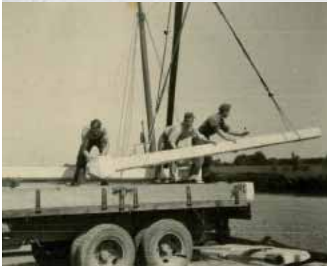
Werknemers van NV Altro, het transportbedrijf van Schokbeton. Jaren vijftig. In het midden Louis den Boer. Collectie: L. den Boer.
